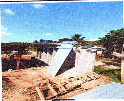
Foto 3: Enlaminado de los Servicios Sanitarios con sistema de drenaje a fosa séptica.
