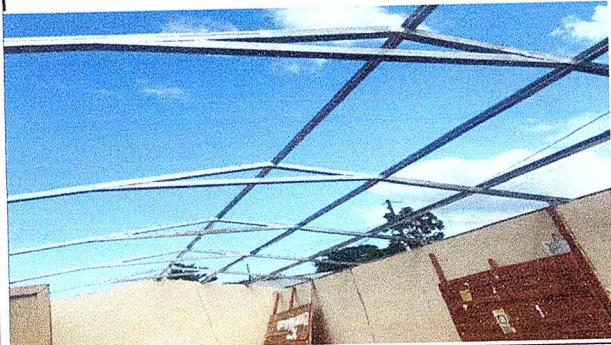
Foto 1: Soldadura de las vigas y costaneras de las 4 aulas para el entechado.
