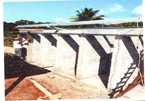
Foto 2: Tallado de las columnas para la colocación de puertas de los servicios sanitarios.
