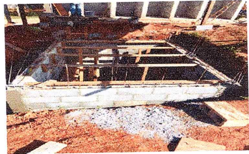
Foto 4: Colocación de formaleta para el entortado de la terraza de la fosa séptica.
